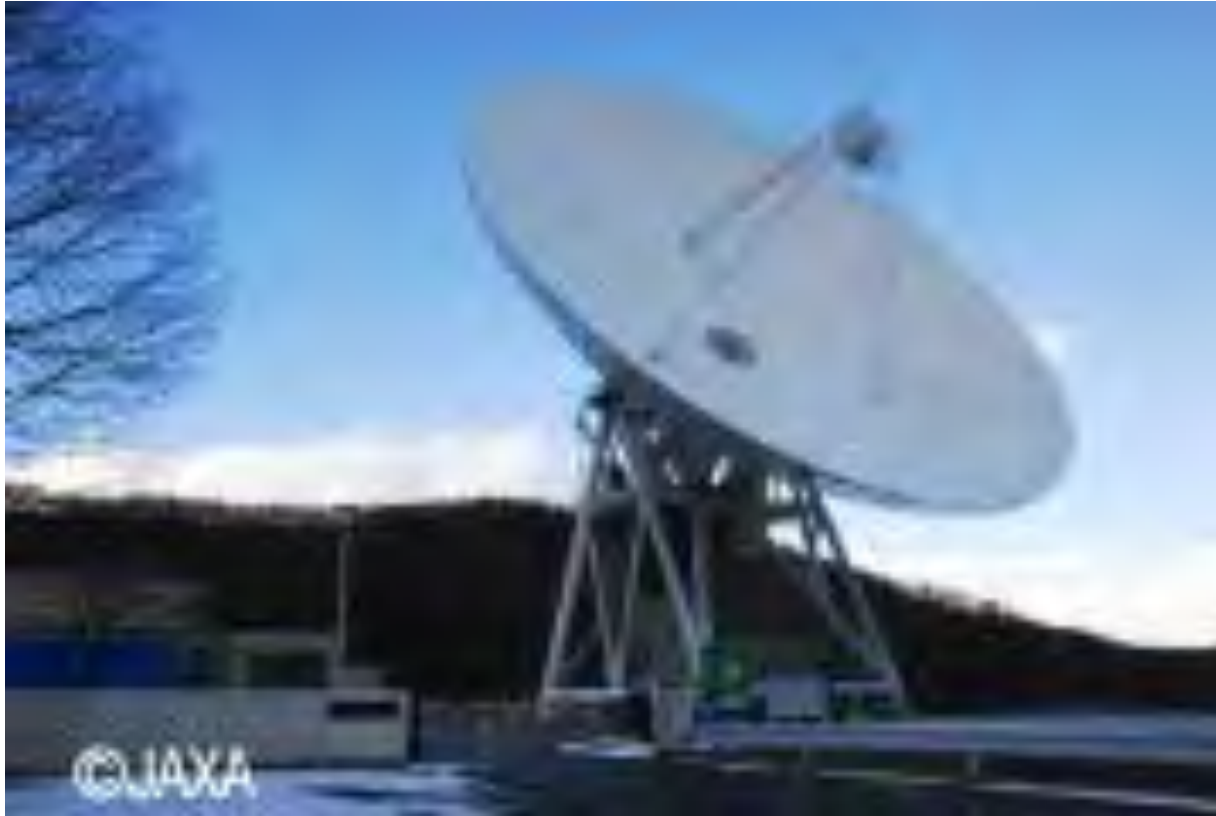
直径64m、臼田にある深宇宙通信用アンテナ 「はやぶさ」からの電波は2700万km彼方の宇宙から届いた。
