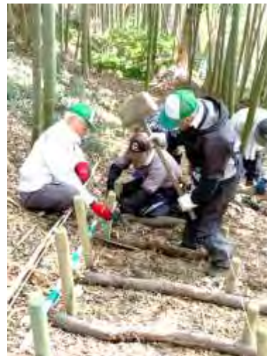
散策路の階段作り
