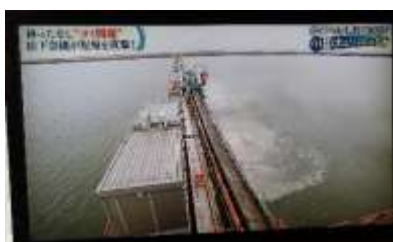
①川崎市浮島処理センター (焼却灰を直接埋立てる)
