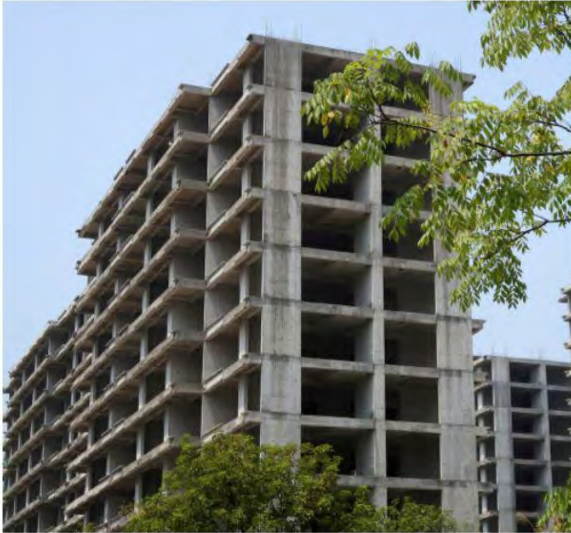
中国南部の広西チワン族自治区に立つ未完成のマンション=ロイター
