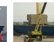
トラック・クレーン
