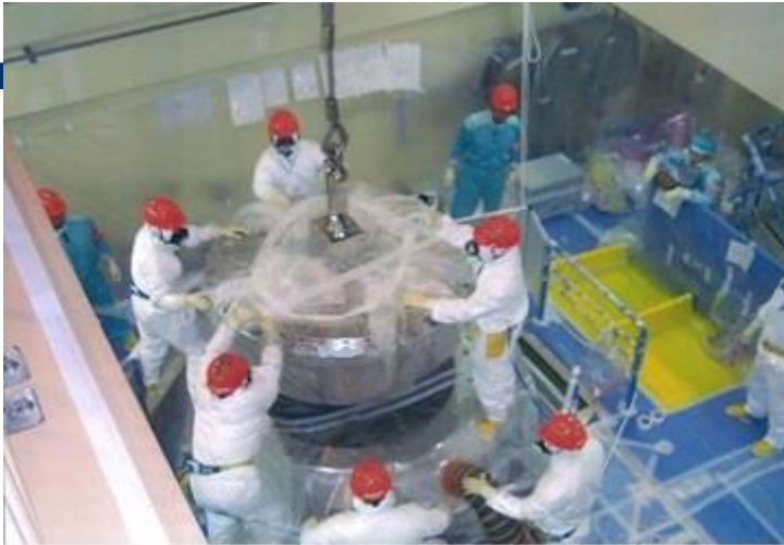
蓋取外し作業実施状況
