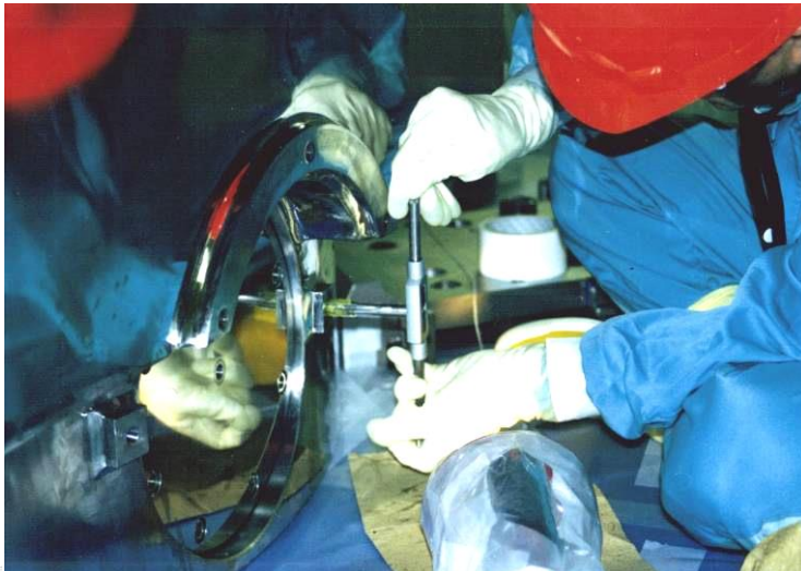
ボルト穴補強作業実施状況
