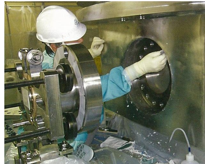
トラニオン取外し作業実施状況
